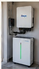
05 | NASIPIT, AGUSAN DEL NORTE 6kW Hybrid + 16kWh Storage
