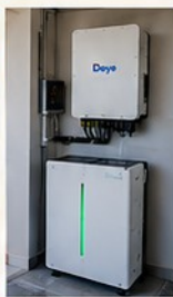
07 | JABONGA, AGUSAN DEL NORTE 6kW Hybrid + 16kWh Storage
