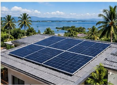
05 | NASIPIT, AGUSAN DEL NORTE 6kW Hybrid + 16kWh Storage
