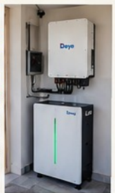
04 | LIBONA, BUKIDNON 6kW Hybrid + 15kWh Storage
